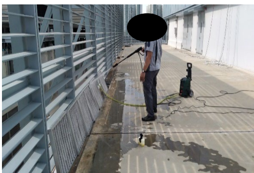
ภาพที่ 2.1-49 การทำความสะอาดแผ่นกรองอากาศ
