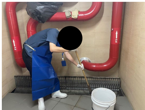
ภาพที่ 2.1-38 การทำความสะอาดรางระบายน้ำ
